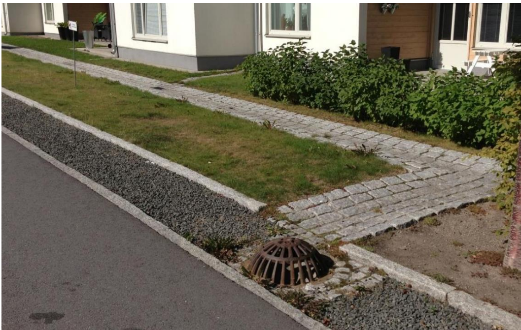
Figur 8 Exempel på mindre vattenförande stråk
